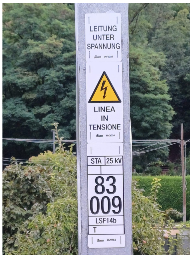
Figura 2: targa di identificazione applicata al sostegno
